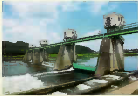
小場江 頭首工
