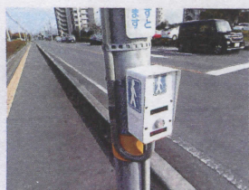
「からだの不自由な方の押ボタン」と黄色の点字ブロック
