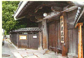
移築する前の水戸東武館 (写真は常陽藝文より)
